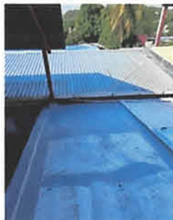
Foto 1: Impermeabilización de techo de Dirección..
